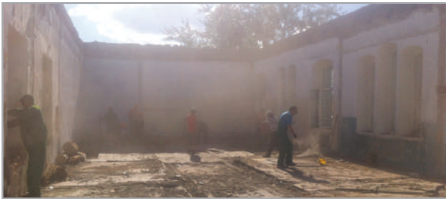
Август, 2017 г. - начало работ
